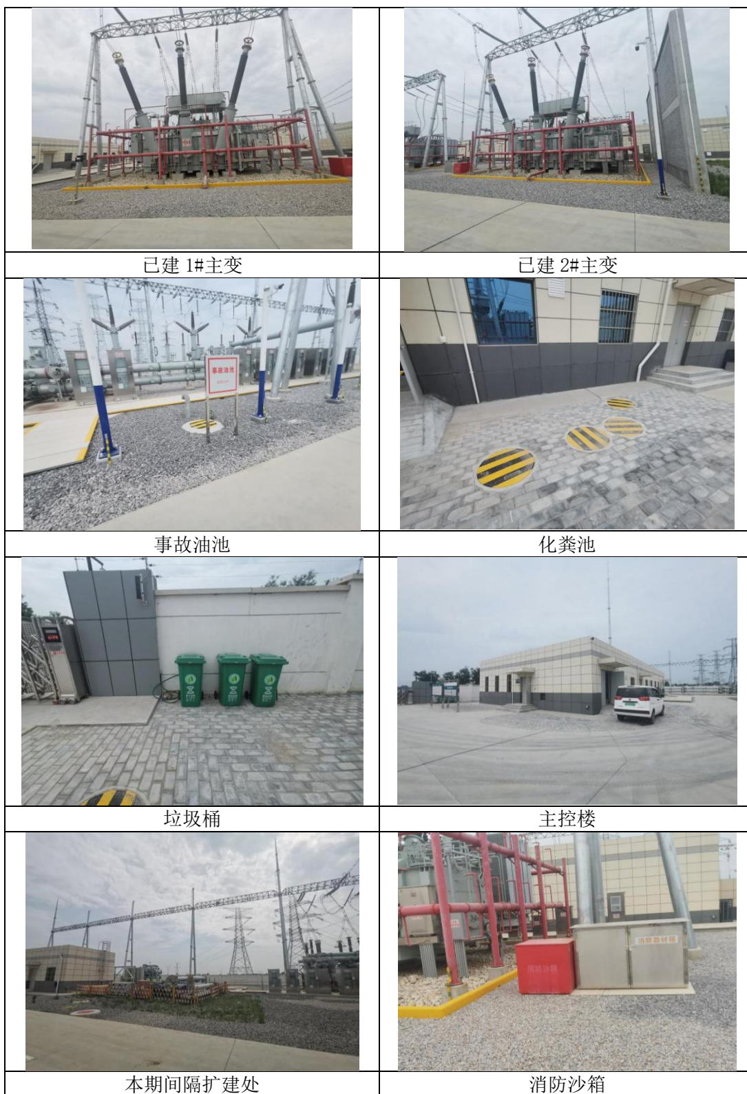
图 1 变电站实景照片
