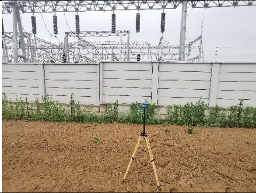
万泉330kV变电站厂界东侧3#
