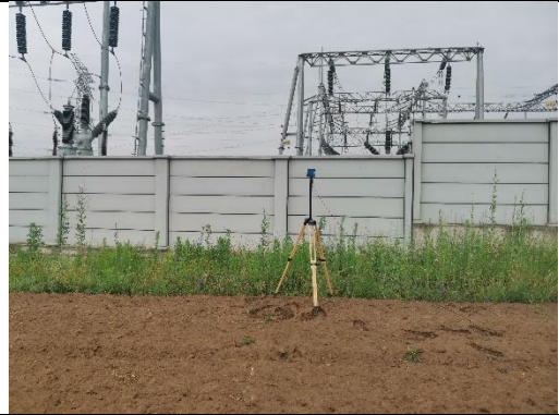
万泉330kV变电站厂界东侧4#
