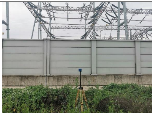
万泉330kV变电站厂界西侧8#
