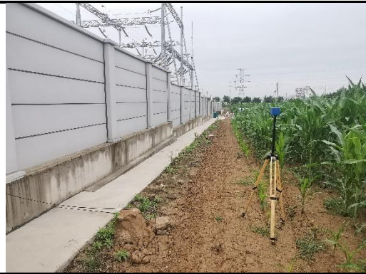
万泉330kV变电站厂界北侧2#
