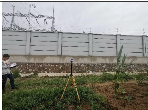
万泉330kV变电站厂界南侧6#
