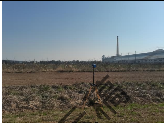
升压站站址西侧图
